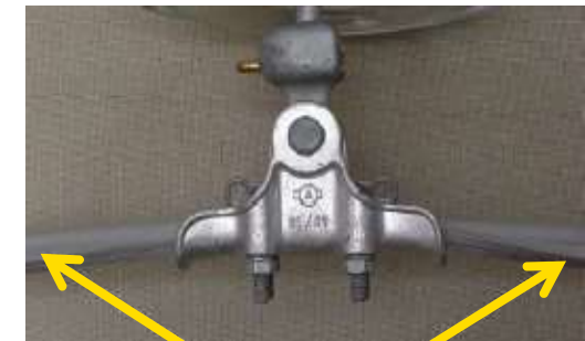
Cobertura flexível de proteção de condutor e fita de silicone auto-vulcanizante
